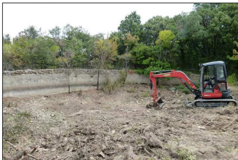
Septembre 2017 – travaux sur la mare de la Condamine
